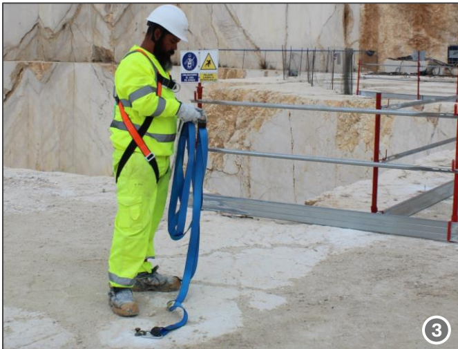
1. Ejemplo de anclaje fijo tipo poste. 2. Ejemplo de anclaje fijo atornillado a varilla de acero. 3. Anclaje fijo a suelo
