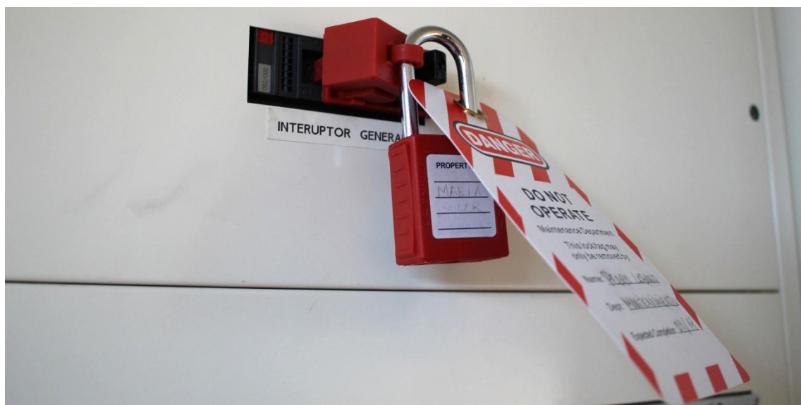
Ilustración 6. ejemplo de interruptor general consignado en un cuadro eléctrico
